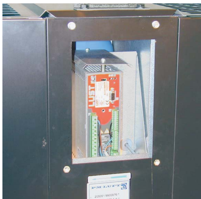
Управляющее снаряжение собрано изнутри боковой крышки. Имеется несколько вариантов его исполнения.
